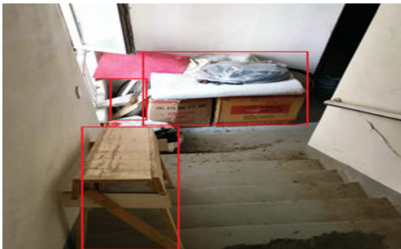
图 3-8 消防通道占用检测 2
